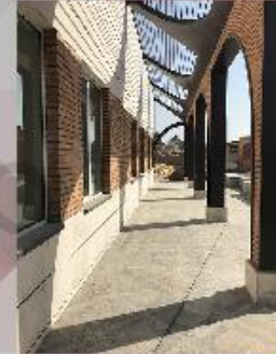
رواق اجرا شده در نمای جنوب شرقی
