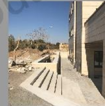
نمای اجرا شده از پلان ورودی
