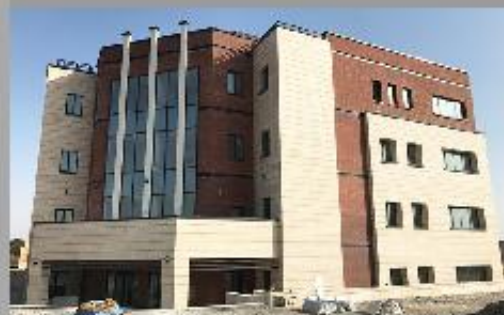
نمای اجرا شده در جبهه جنوبی
