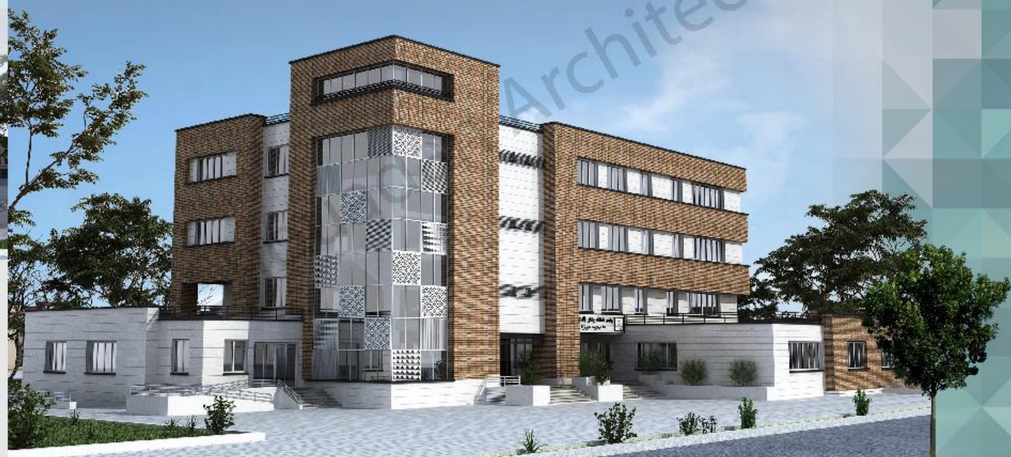
ورودی مجموعه - ضلع شمالی
