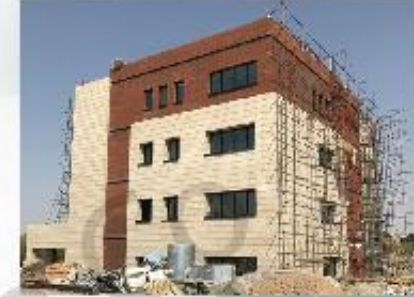
نمای اجرا شده در چپه شمال غربی
