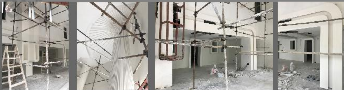
فضاهای داخلی اجرا شده
